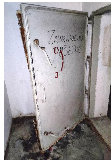
Слика 3. Корозија и оштећена заптивна трака на вратима у склоништу, Вајара Живојина Лукића 10, Београд, 2023. година, фото ДРИ
