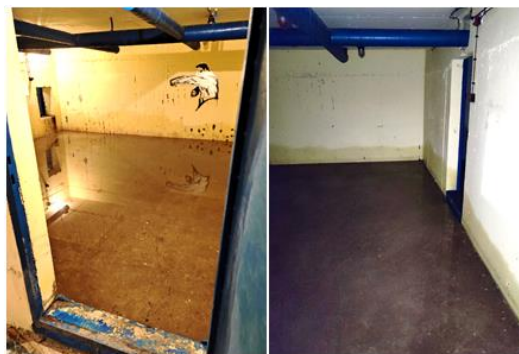
Слика 11. Присуство воде и влаге у склоништу, Гундулићева 2, Панчево, 2023. година, фото ДРИ
