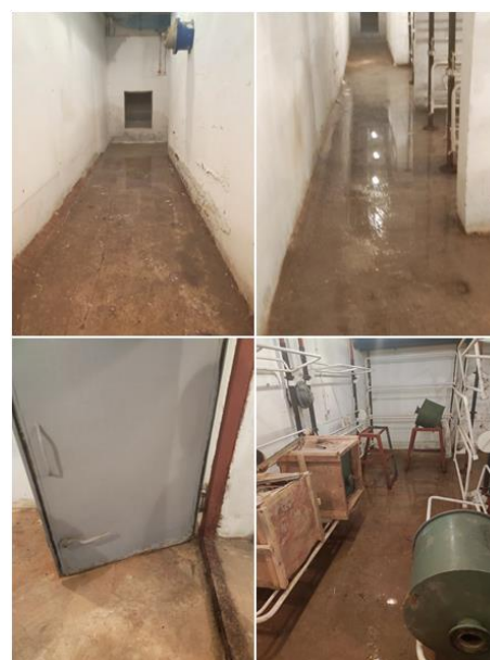
Слика 9. Присуство воде и влаге у склоништу, Незнаног јунака I/II, Крагујевац, 2023. година, фото ДРИ
