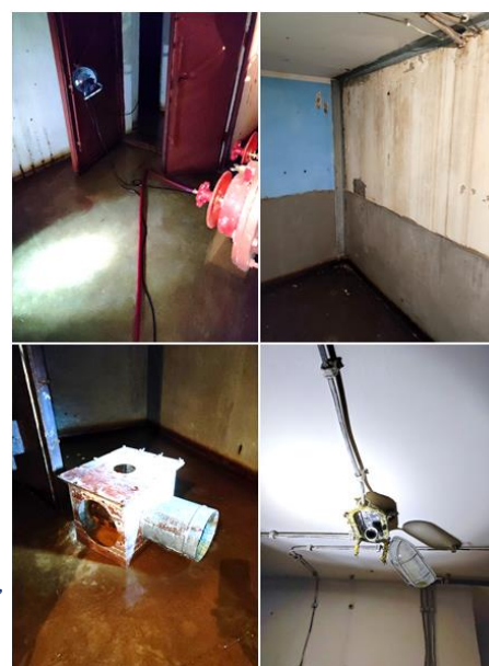
Слика 8. Црпљење воде и последице плављења склоништа, Младена Митрића 4, Београд, 2023. година, фото ДРИ
